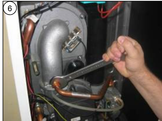
6 Überwürfe der Gasstrecke lösen und ab- drehen, Gasrohr abnehmen, Gasdüse und Dichtung aus Mischkanal entnehmen
