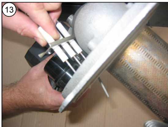
Bei Bedarf Elektrodenblock und / oder Brennerisolierung austauschen
