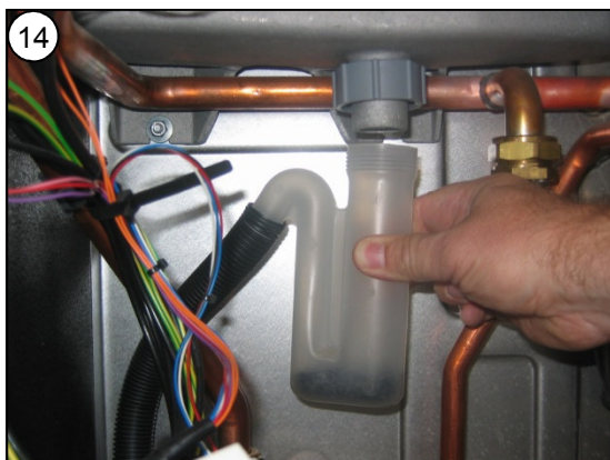
Siphon auf Verschmutzung prüfen, evtl. vor weiteren Arbeiten reinigen, dazu Überwurf lösen und Siphon abziehen
