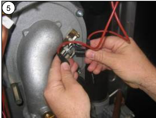
5 Zündelektrodenstecker abziehen und Erdungstecker abziehen
