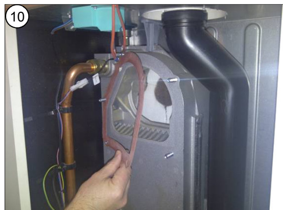
10 Brennerdeckeldichtung entfernen und Dichtflächen ggf. reinigen
