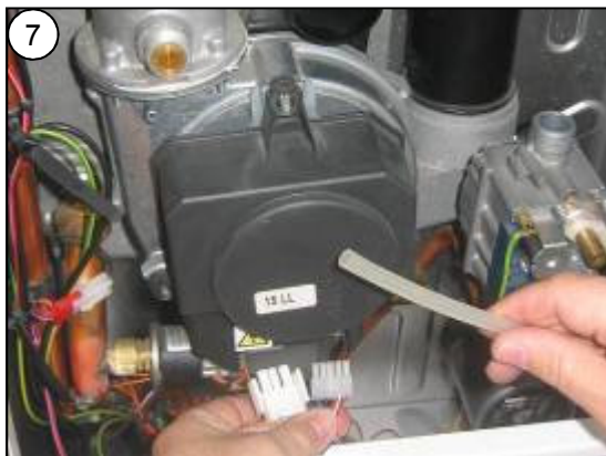
7 Druckverbundschlauch und Stecker am Lüfter abziehen
