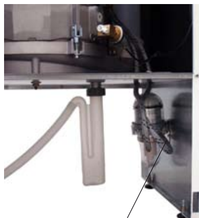
Ölfilter im Heizkessel montiert
