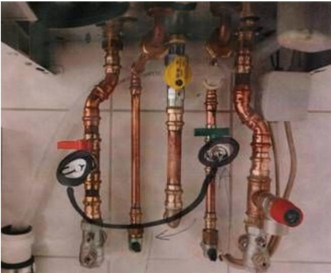
Der Chef des Installationsunternehmens schlägt vor, zum Nachfüllen von Heizungswasser das Rohr ganz links und das vierte Rohr von links mit einem Schlauch zu verbinden. Der Heizungsrücklauf ist jedoch das Rohr ganz rechts. - Der Filzstiftstrich stammt vom Chef des Installationsunternehmens ... abgesehen vom fehlenden Systemtrenner.
